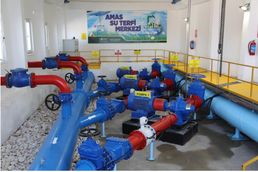
Şekil 3. Terfi İstasyonu Pompa Yerleşimi [4]
